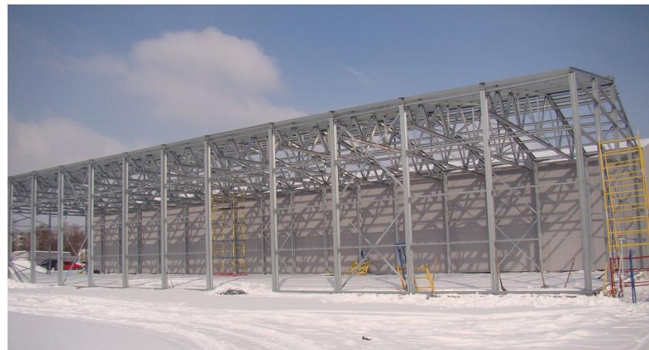
Вторичные элементы каркаса представляют собой конструкции, предназначенные для крепления стенового ограждения (система стеновых прогонов), установки окон, ворот и дверей (каркасы проемов), светоаэрационных фонарей и т.д.
