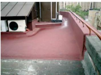
Благодаря великолепной адгезии к капиллярно-пористым и битумным материалам, создается бесшовное эластичное, износостойкое гидроизоляционное покрытие не боящееся ультрафиолетовых солнечных лучей. Исключаются хлопоты и лишние расходы, связанные со снятием и утилизацией демонтируемых материалов, периодическим ремонтом приходящего в негодность старого покрытия.
