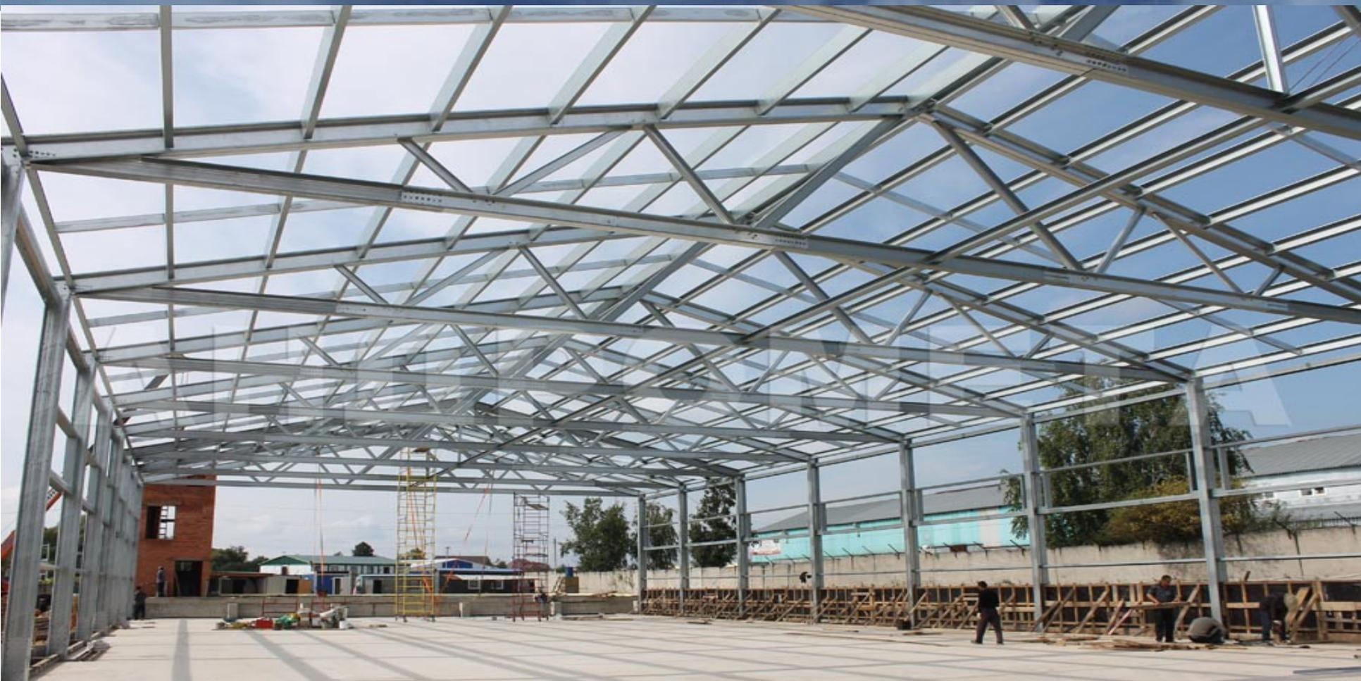
Каркасы изготавливаются из высококачественной отечественной горячеоцинкованной стали (С 345 по ГОСТ Р 52246-2004 с покрытием 275 г/кв.м).
