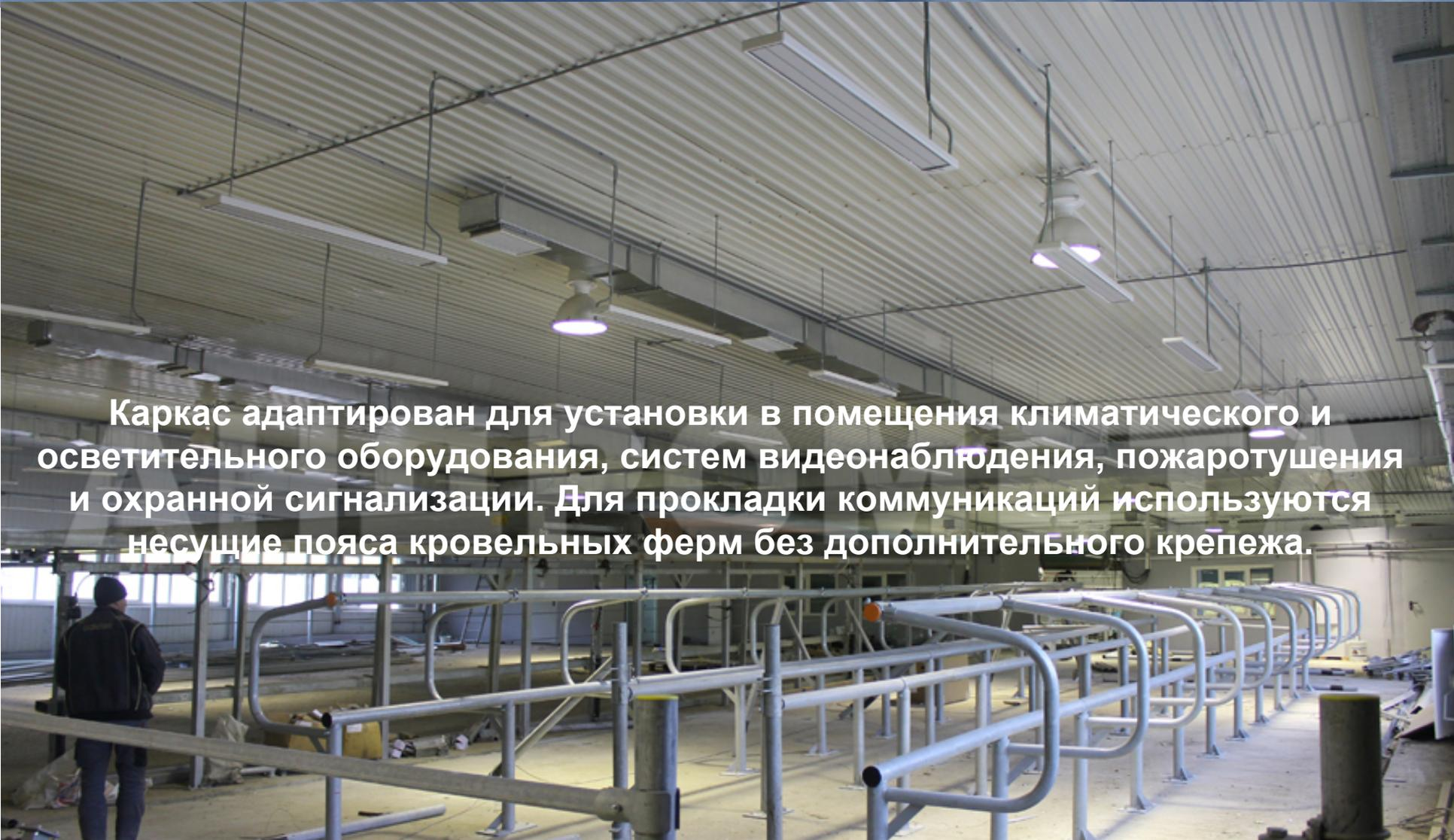
Каркас адаптирован для установки в помещениях климатического и осветительного оборудования, систем видеонаблюдения, пожаротушения и охранной сигнализации. Для прокладки коммуникаций используются несущие пояса кровельных ферм без дополнительного крепежа.
