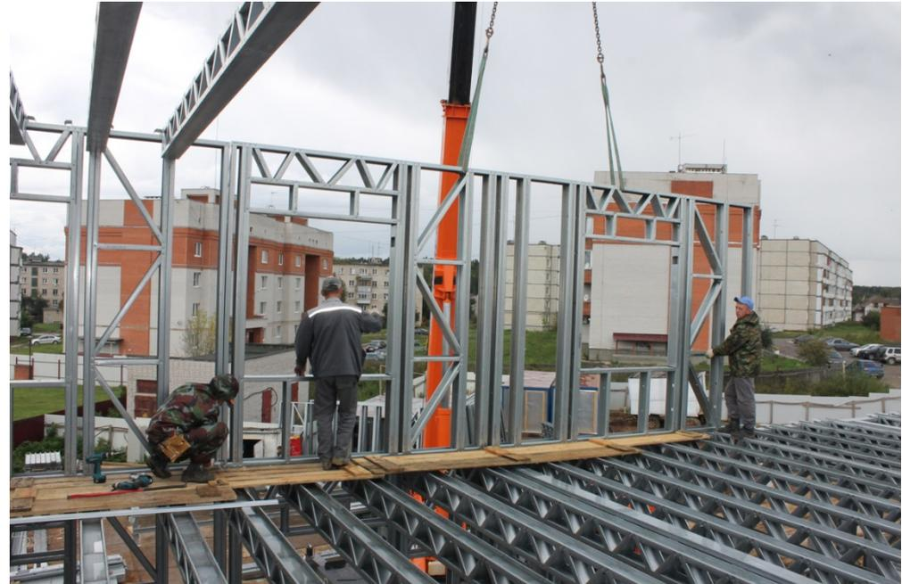
**Сборка каркаса здания осуществляется путем установки панелей в проектное положение согласно чертежам и последующего крепления к другим панелям каркаса. Сборка панелей осуществляется при помощи самонарезающих винтов, соединение панелей между собой - при помощи самонарезающих винтов или болтов нормальной прочности.**
