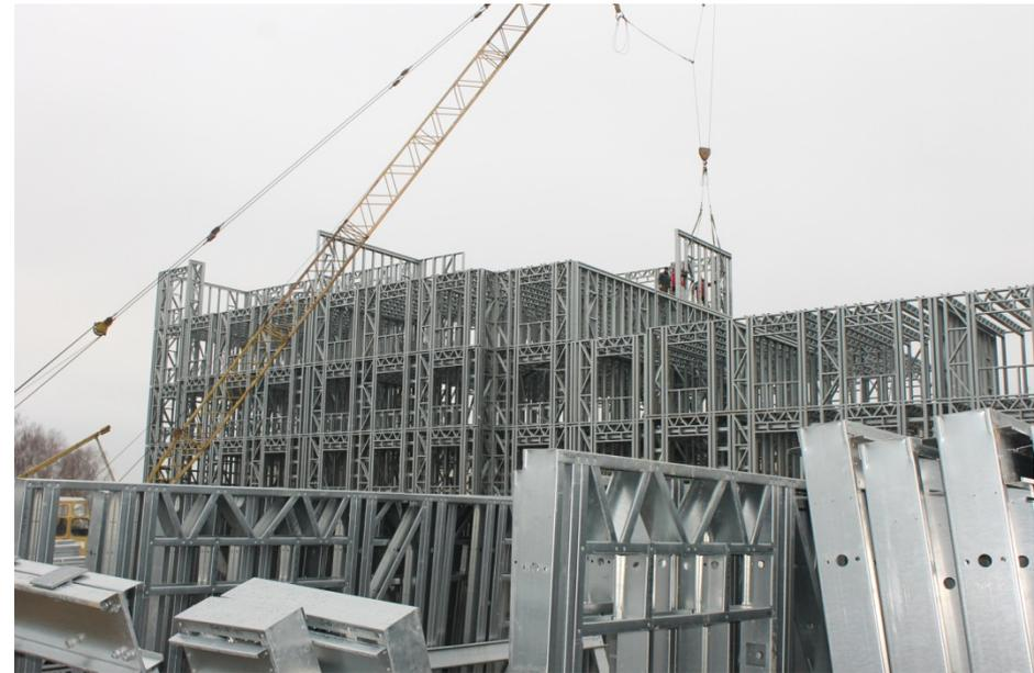
**Каждая линейная деталь выполнена в необходимый размер и имеет все отверстия и вырезы, предназначенные как для установки ее в панель без измерительных процедур (маркировки и позиционирующие элементы), так и для ее крепления к другим деталям панели (крепёжные отверстия).**
